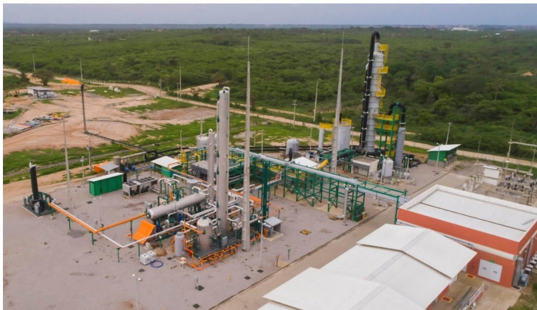
Usina de Biogás – Caucaia-CE
